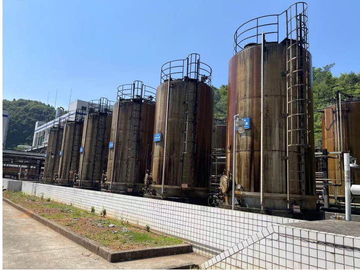
图2：大明山区块化工液体罐区
